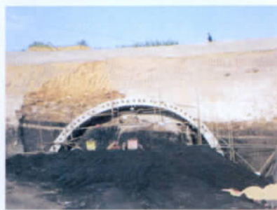
图4 郭家川 2# 隧道洞口护拱
