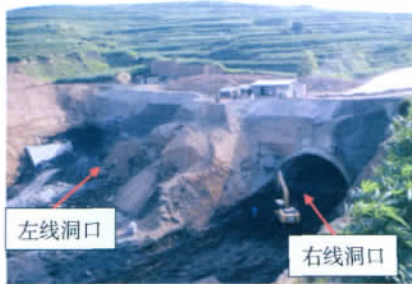
图 1 郭家川 2 # 隧道新乡端洞口
