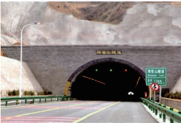
图16 过渡段护栏设置
