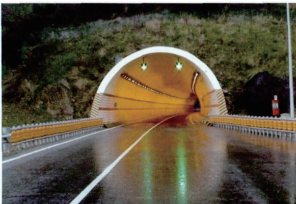
图17 旋转式防撞护栏
