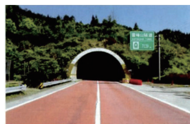
图14 洞口防滑构造
