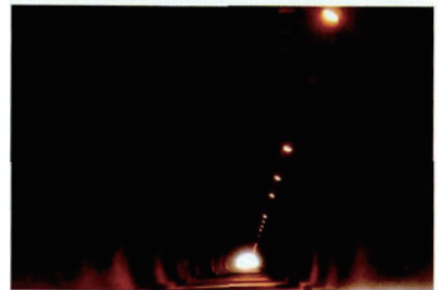
图12 隧道洞内照明不良
