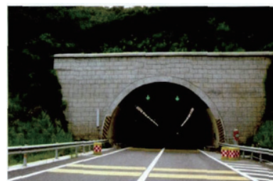
图7 过渡护栏设置不合理
