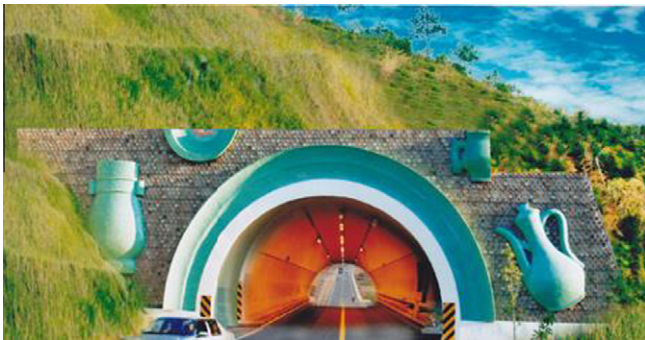
Fig. 29. Portal of Mifengling tunnel.
